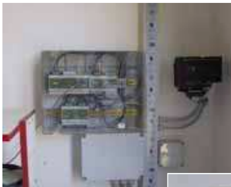
Il modulo controllore programmabile e il ripetitore di segnale
