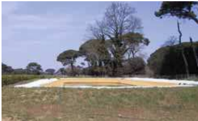
La vasca di accumulo
